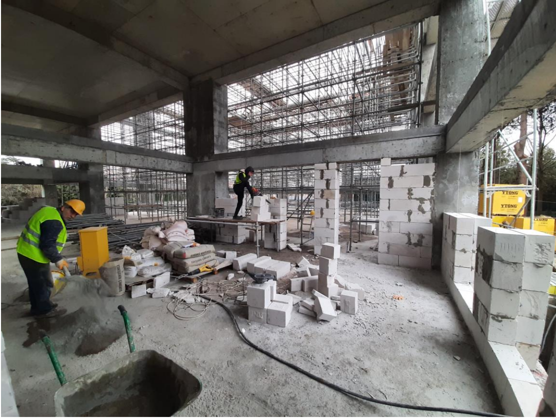
Hamidiye Külliyesi Mekteb-i Tıbbiye-i Şahane Binası 2. Etap Restorasyonu
