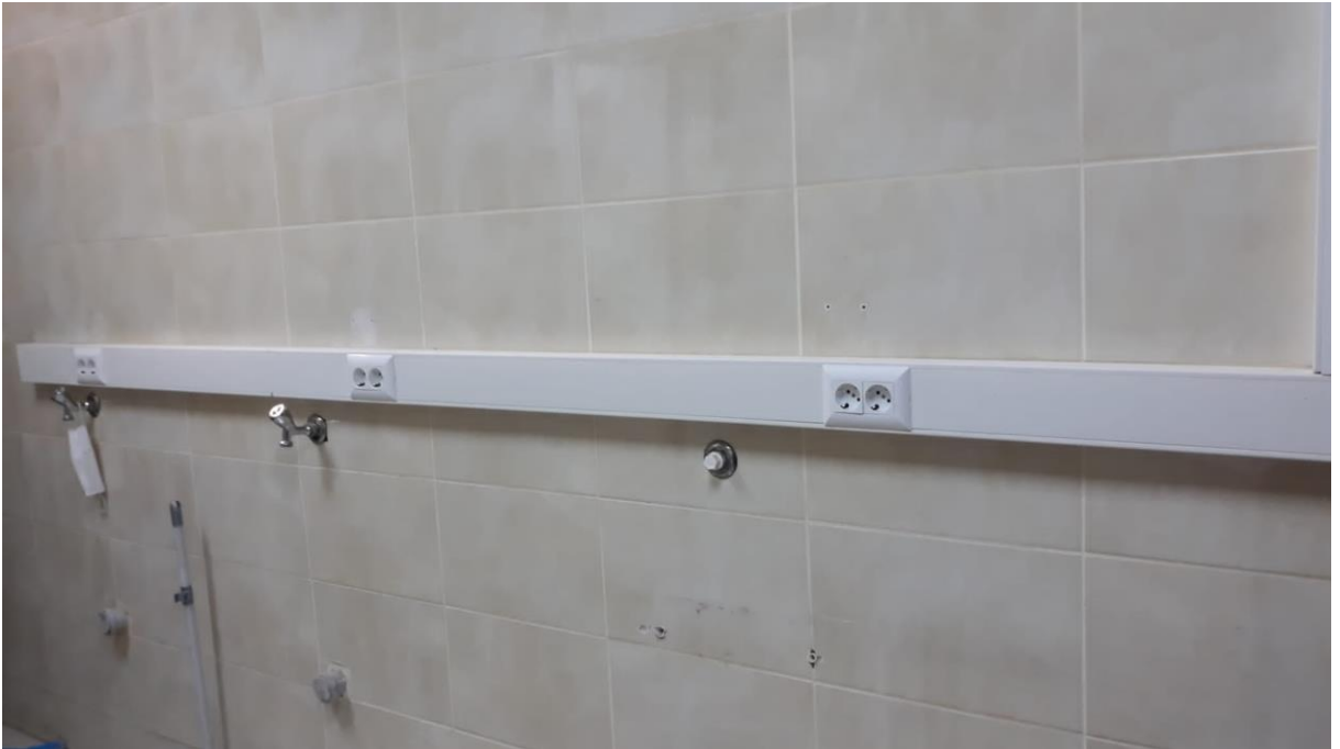
G lhane K llyesi Yurt Binaları  amařırhane Yapılması İři
