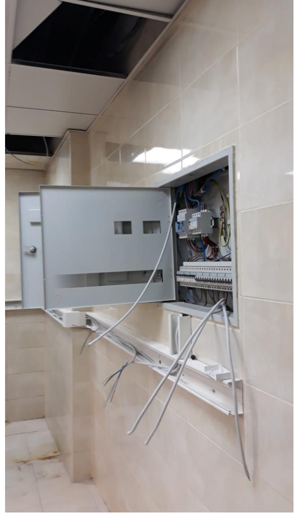
G lhane K llyesi Yurt Binaları  amařırhane Yapılması İři
