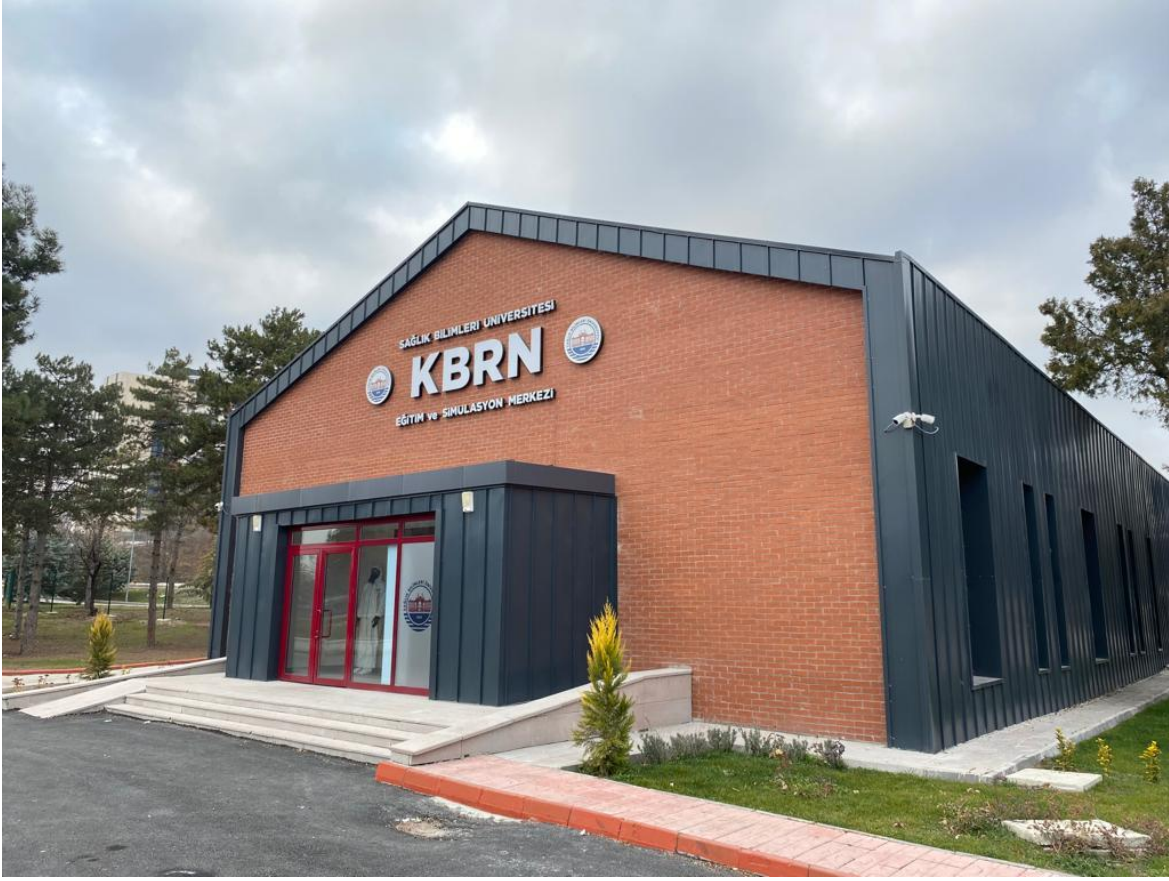
Gülhane Külliyesi KBRN Simülasyon ve TEKMER Eğitim Merkezleri Onarımı
