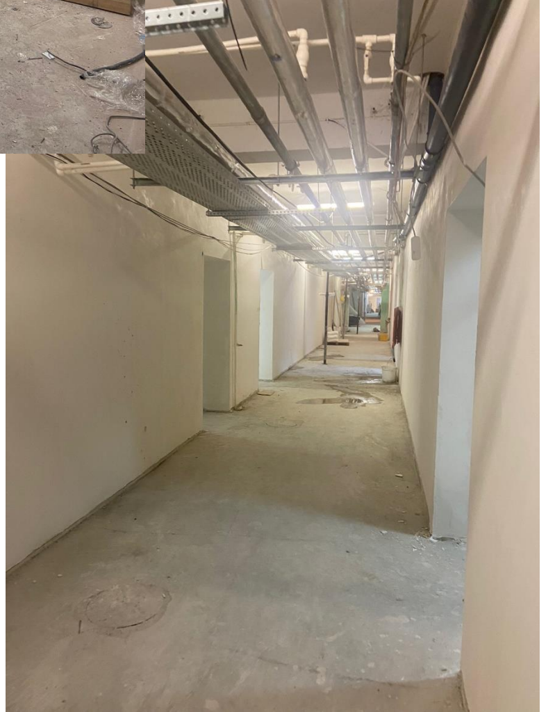
Medikal Cihaz Test Kalibrasyon Ar-Ge Eğitim ve Belgelendirme Merkezi için Validebağ Binasının Tadilatı
