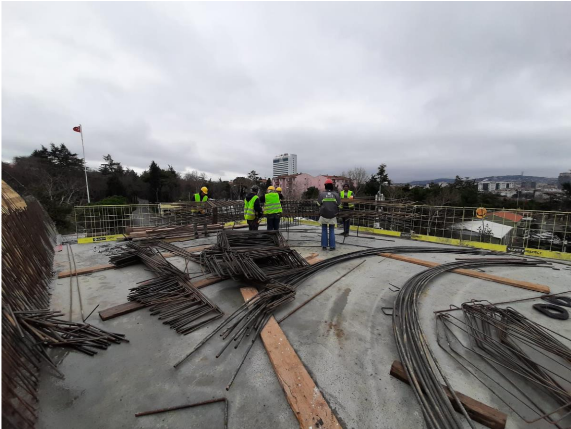
Hamidiye Külliyesi Cami İnşaatı
