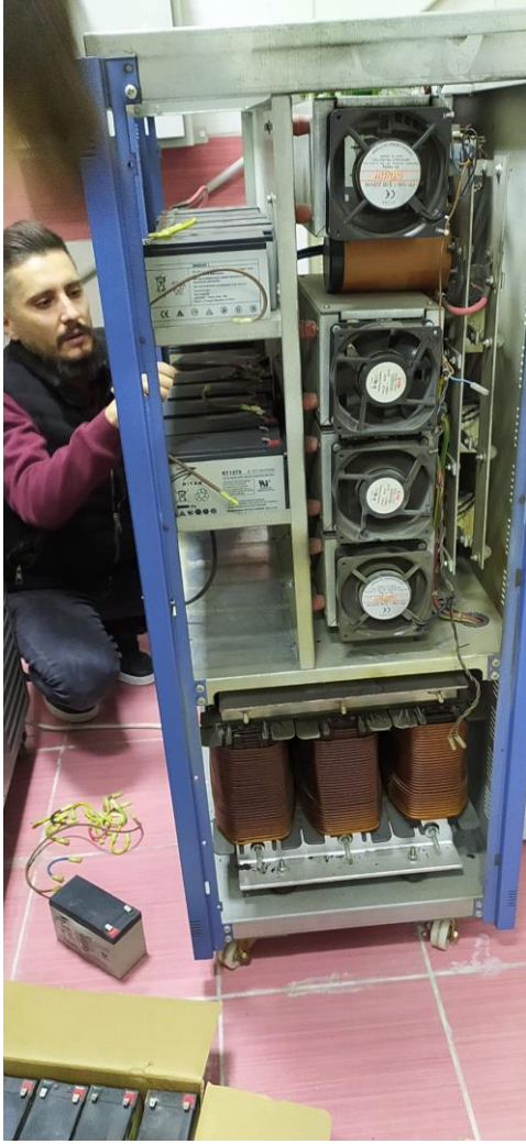
G lhane K llyesi UPS Bakım Onarım  alıřmaları
